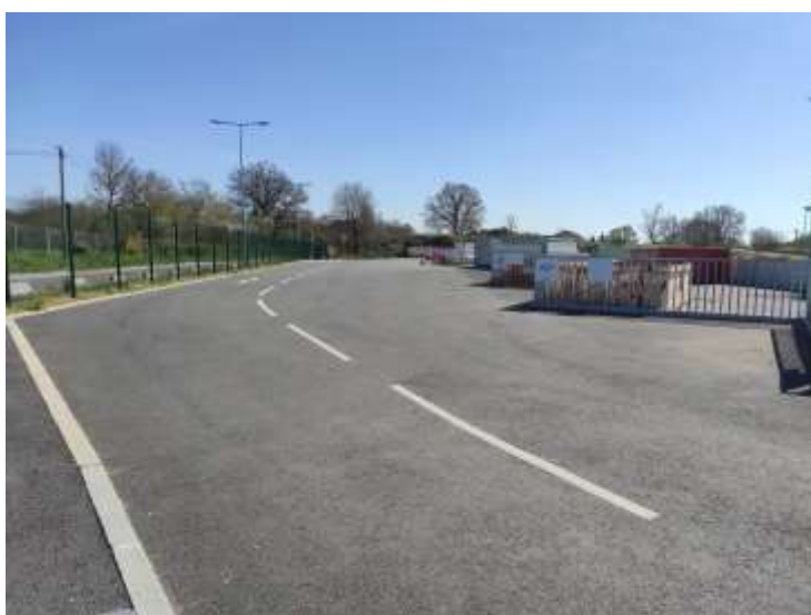
Déchetterie du Petit Râteau, Vierzon
