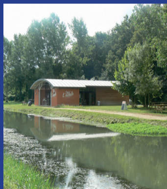
Aménagement de l'air d'accueil sur les bords du Canal de Berry à Théniau
