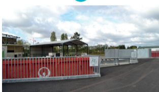
Réhabilitation de la déchetterie du Petit Râteau à Vierzon
