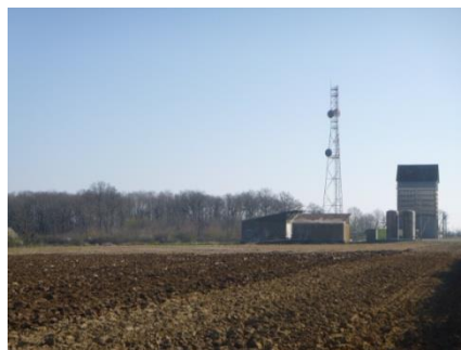
Silo – gros ouvrage non intégré au paysage
