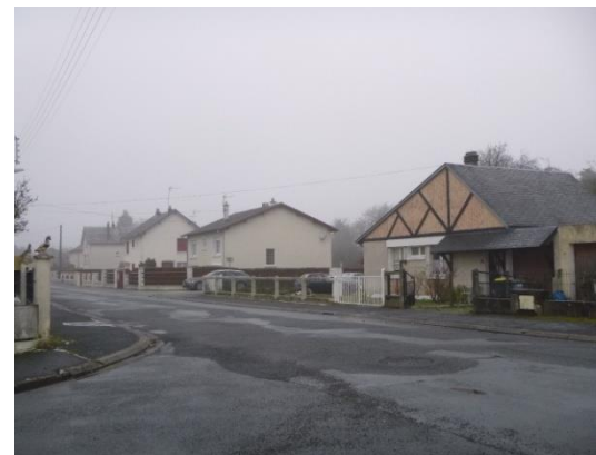
Rappel de l'architecture rurale traditionnelle sur une maison récente à Vierzon
