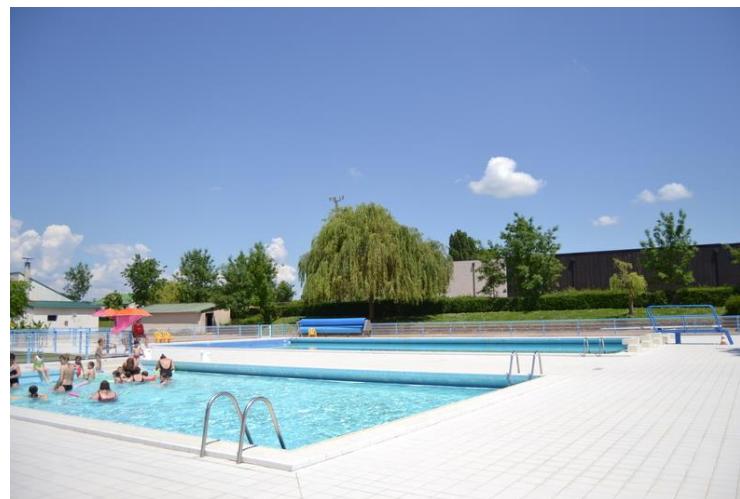
Piscine intercommunale de Graçay (Source : CC Vierzon Sologne Berry)
