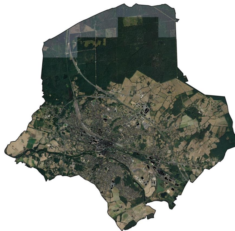
Emprise forestière – Forêt domaniale sur tout le tiers nord de la commune de Vierzon
