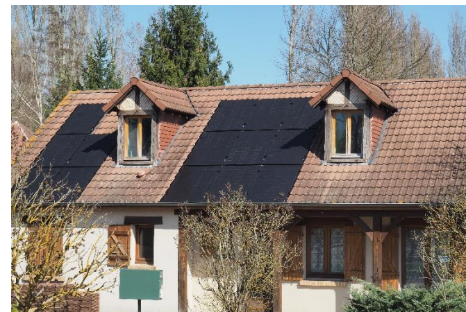
Figure 37 : installation photovoltaïque individuelle sur la commune de Foëcy (source : Biotope)
