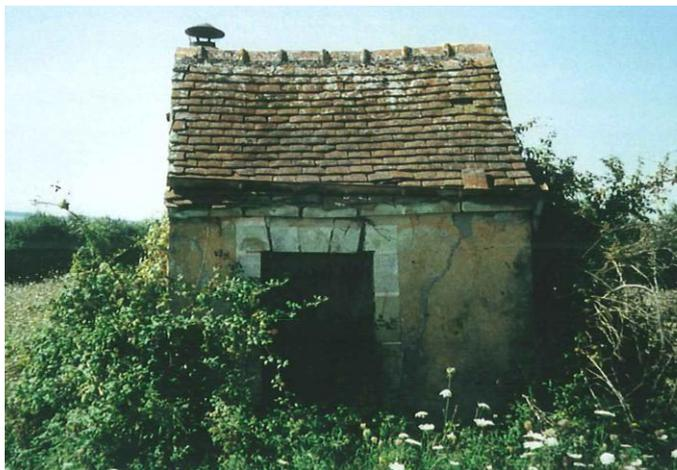
La cabane est partiellement envahie par les ronces ; visiblement hors d'eau, des infiltrations plus ou moins importantes doivent apparaître par gros orages. Toit à doubles pentes classique constitué de vieilles tuiles, partiellement abîmées par endroits.
