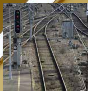
Réalisation du projet de port sec
